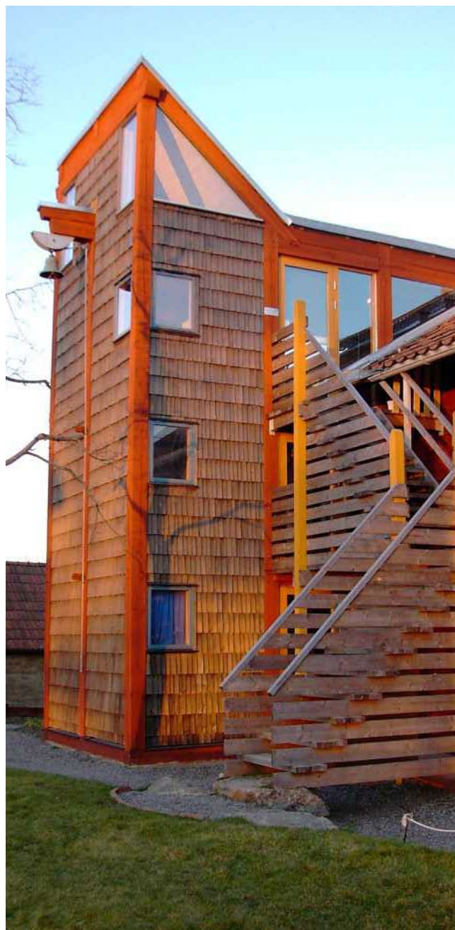
Till det ursprungliga magasinet har det byggts ett torn som inrymmer en hiss, toaletter, vatten och avlopp.
